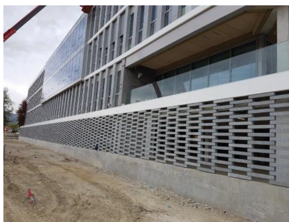
La Motte-Servolex - Siège du Crédit Agricole des Savoie Wilmotte & Associés Pierre de San Bernardino
